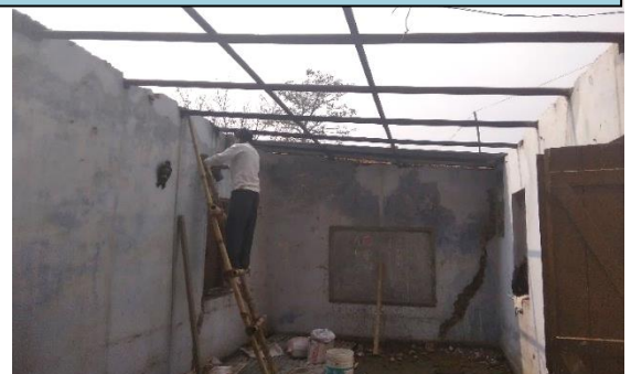
Nach der Entfernung der alten Asbestos-Dachplatten.
