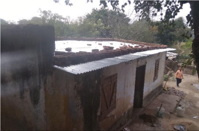
Nach der Installation der neuen Dachplatten
